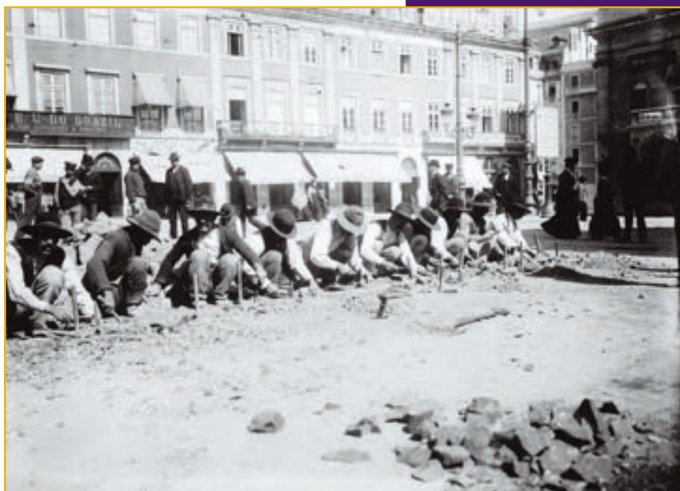
Obras Municipais: calceteiros 1
